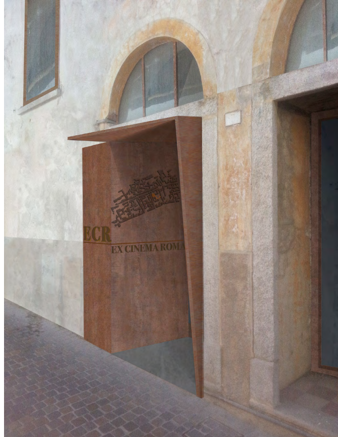
Vista dell' ingresso da via Cavour
